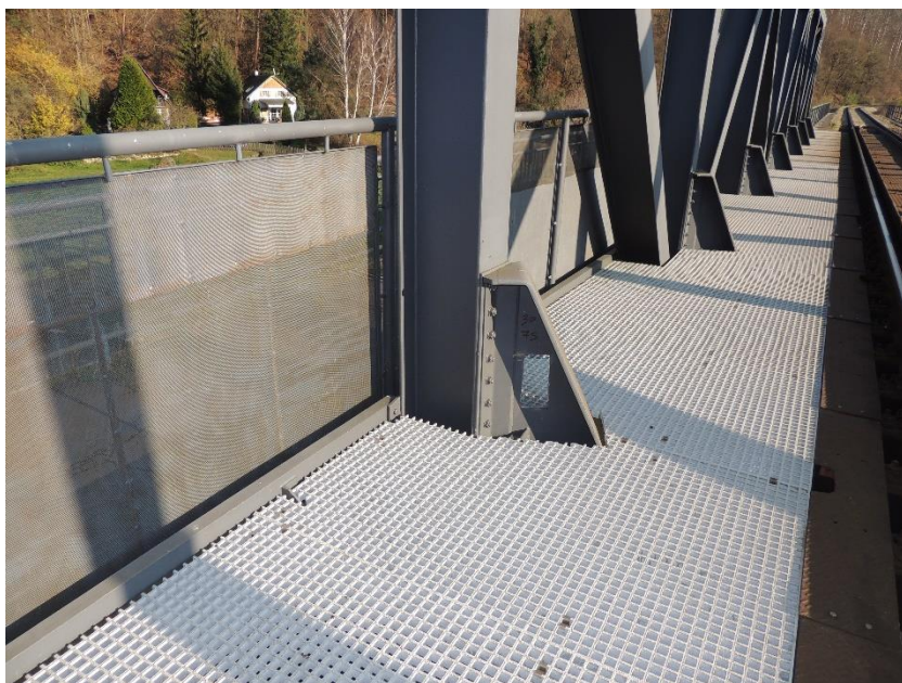
Místo odběru vzorku číslo 3P 7S ze svislého plechu spojení příčnicku a svislé části podélníku
