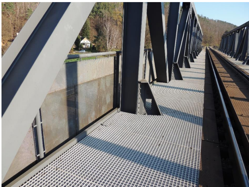
Místo odběru vzorku číslo 1P 13S ze svislého plechu spojení příčnicku a svislé části podélníku
