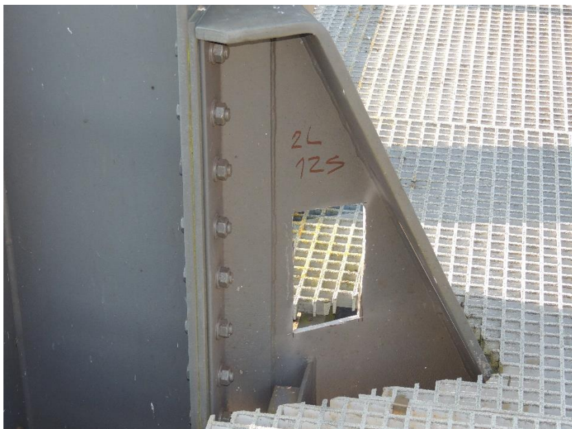
Místo odběru vzorku číslo 2L 12S ze svislého plechu spojení příčnicku a svislé části podélníku
